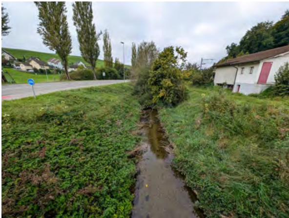
Blick von Brücke Schottikerstrasse in Fließrichtung
