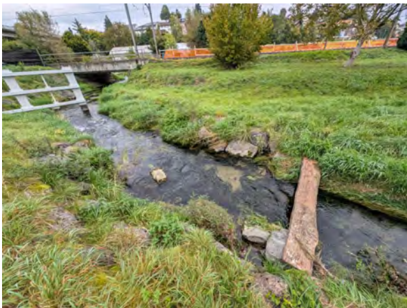
Blick in Fließrichtung
