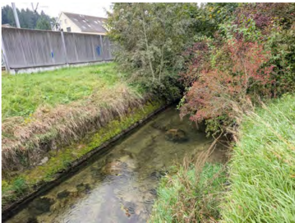
Blick in Fließrichtung (Standort: westlich Coop)
